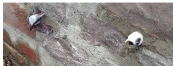
Verfüllpacker mit Entlüftungsschlauch, für Anschluss Schnellschnappverschluss | Injecteur de remplissage avec tuyau de purge, pour raccord de raccord rapide
