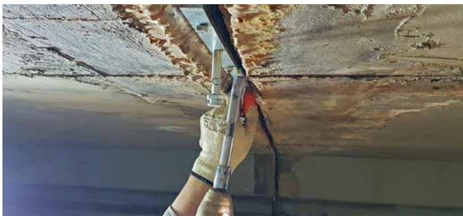
Einbau und Befestigung des DESOI Quick Seal
