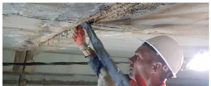
Nach Aushärten des Füllstoffes DESOI Quick Seal einfach entfernen
