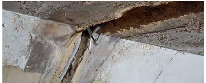
DESOI Quick Seal setzen, beginnend mit dem Rechteck-Stahlpacker
