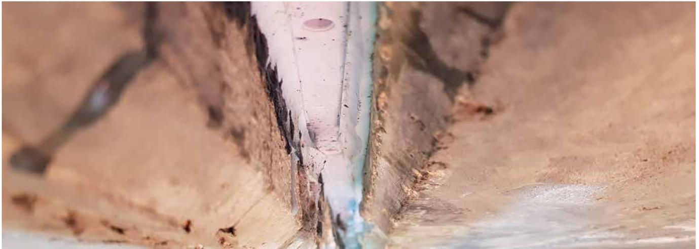
Erfolgreiche Sanierung der Fuge mit dem DESOI Quick Seal und dem Rechteck-Stahlpacker | Successful rehabilitation of the joint with DESOI Quick Seal and the rectangular steel packer
